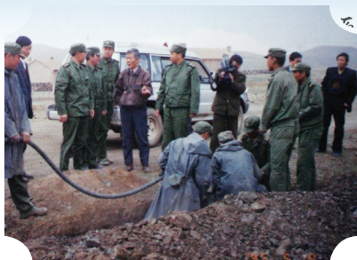
1995年8月张春生局长到光缆工地慰问施工的战士(11)
